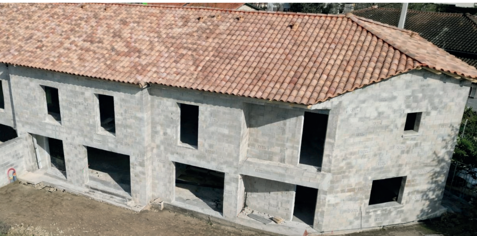
Chantier Frouzins en blocs Airium
