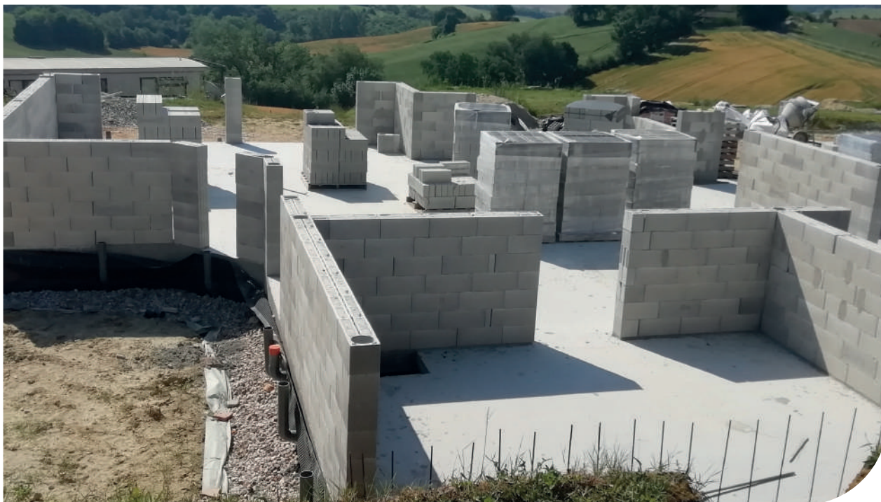
Chantier en blocs Airium
