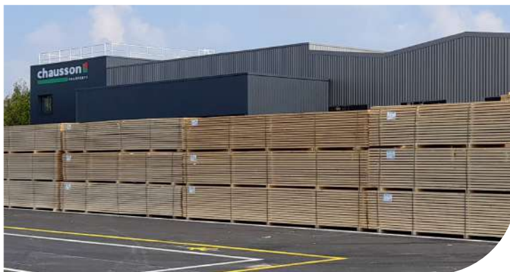
Usine de charpente - Fontenay-Le-Comte (85)
