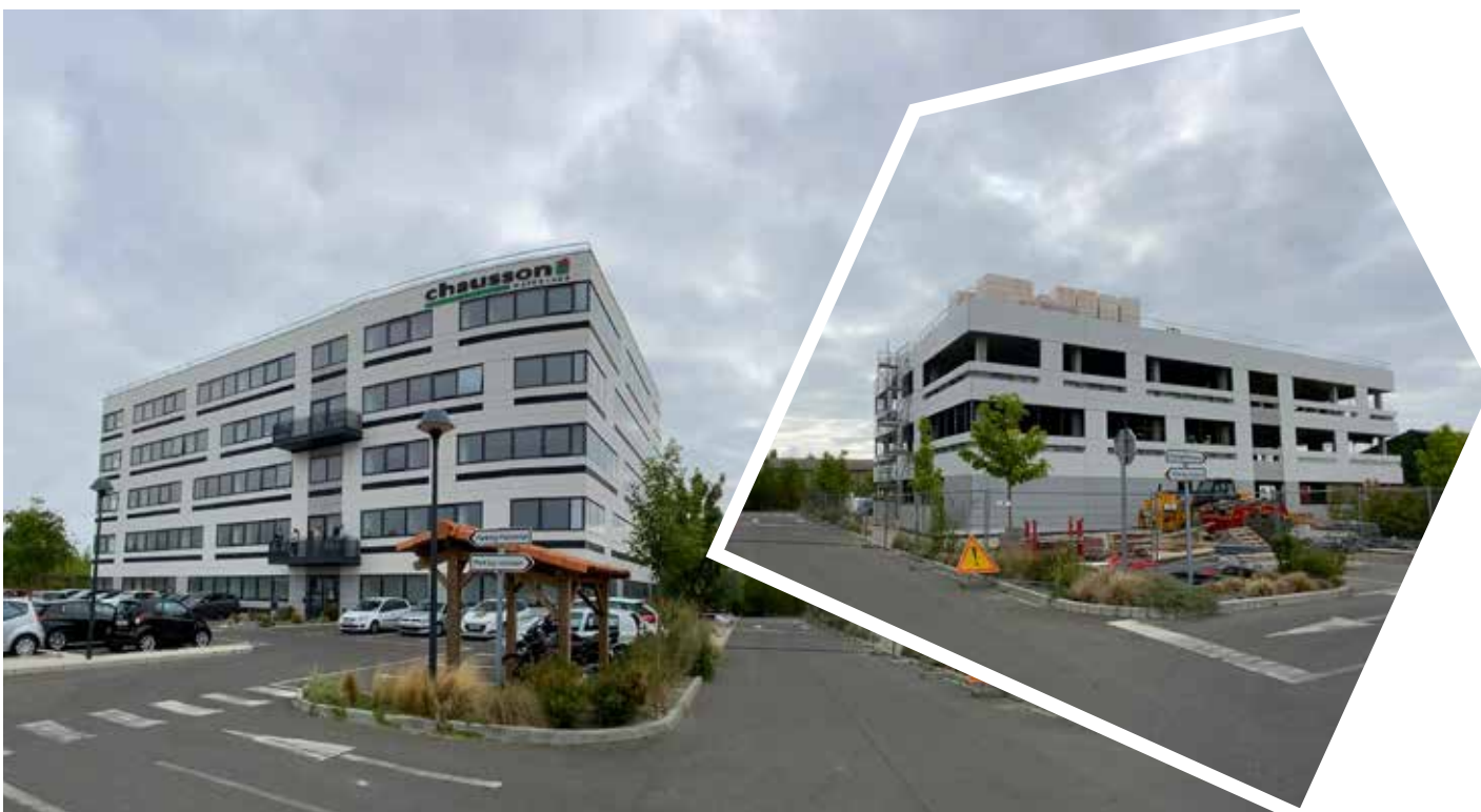
Travaux d'agrandissement du Siège Social de Saint-Alban (31)
