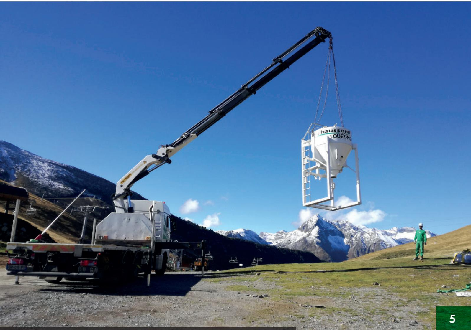
Déversoir Barrage de l'Oule (65) – Projet Héliporté avec environ 30T de CLAVEX 708 MB +
