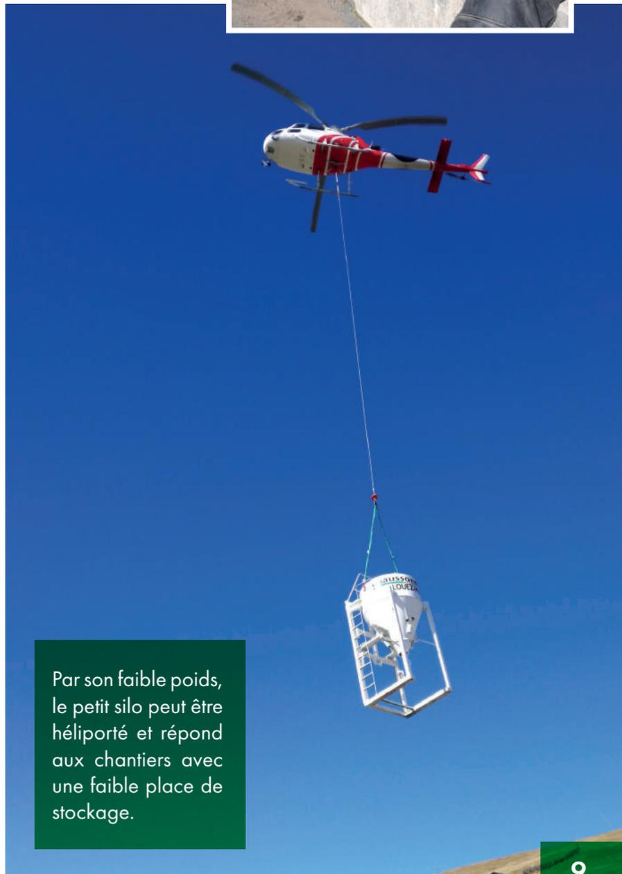
Par son faible poids, le petit silo peut être hélicopté et répond aux chantiers avec une faible place de stockage.
