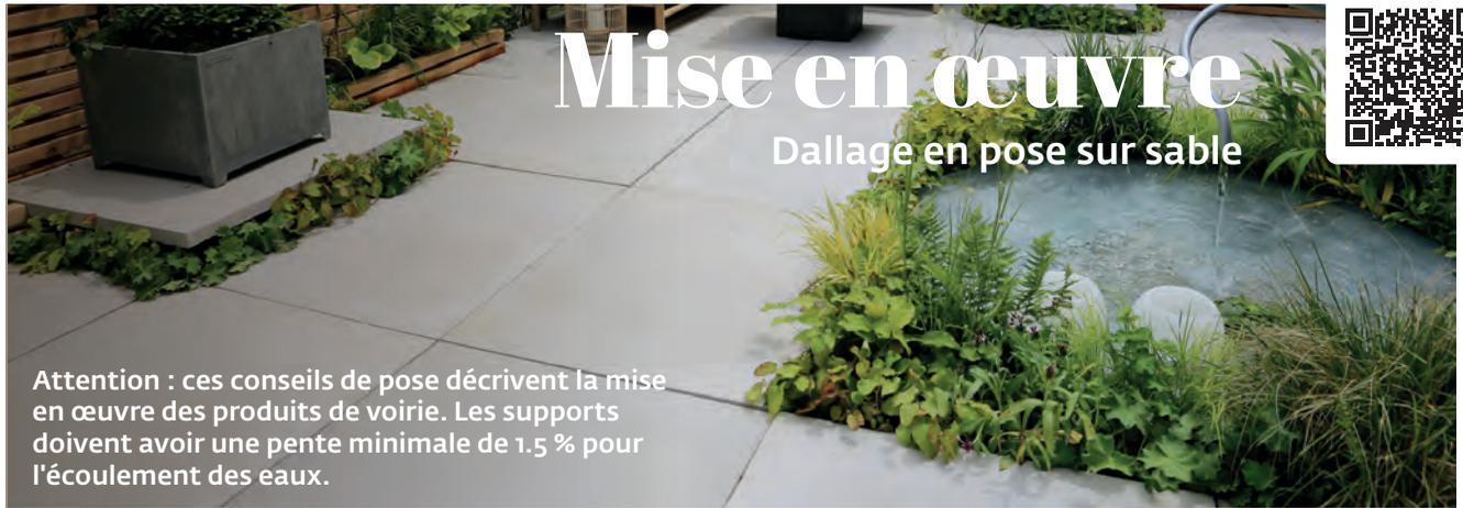
Attention : ces conseils de pose décrivent la mise en œuvre des produits de voirie. Les supports doivent avoir une pente minimale de 1.5 % pour l'écoulement des eaux.
