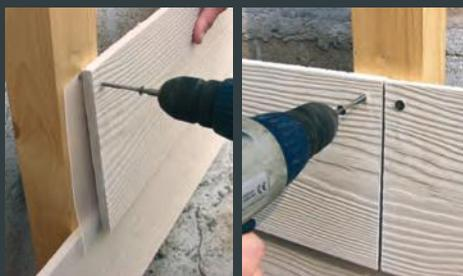
3. À partir du 2ème rang, ne pas oublier la bande de joint sur le chevron à la jonction de 2 lames et un recouvrement de 30 mm de la lame précédente
