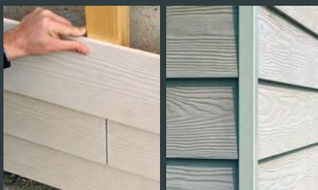
4. Pose rangée par rangée en décalant les joints. Finition des angles avec un profilé
