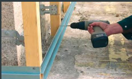
1. Mise en place de la grille d'aération anti-rongeurs puis du profil de départ
