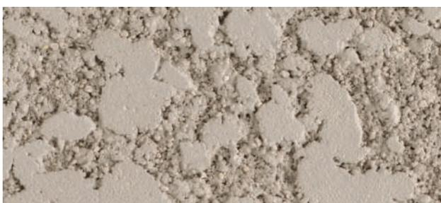
La finition «rustique écrasée» n'est pas uniforme. Les parties écrasées sont plus claires que les parties laissées texturées. Cet effet moucheté s'obtient en écrasant le mortier encore frais.
