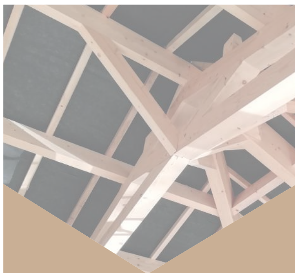
CHARPENTE / STRUCTURE P.7
