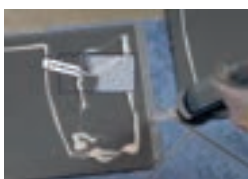
4. Sous la douche : pose d'un joint d'étanchéité
