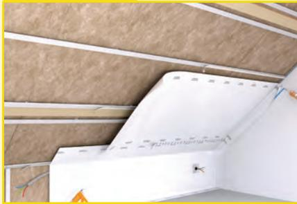
Fixer les fourrures sur les suspentes et les lisses au sol et au pied droit.
