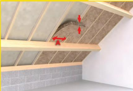
Pose de la 1<sup>ère</sup> couche et fixation des suspentes à entraxes :
