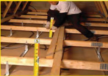
Reconnaissance du comble et vérification du bon état du support (pas de trace d'humidité, résistance, étanchéité à l'air).
