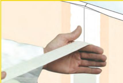
La bande est micro-perforée pour un bon séchage de l'enduit, meulée sur une face pour favoriser l'adhérence, munie d'un axe visible pour centrer la bande sur le joint et faciliter le pliage pour les angles. Placer la bande sur l'axe du joint, partie meulée côté plaque.
