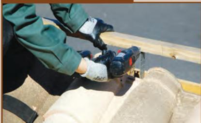
Positionner et fixer l'étrier support de lisse sur la charpente à 5 cm environ au-dessus du dernier rang de tuiles. Installer la rehausse.
