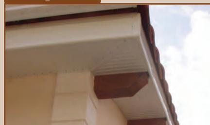
Emboîter les angles avec un jeu de dilatation de 10 mm. Utiliser le profil de jonction « H » pour le raccordement des sous-faces et prévoir un support du profilé dans le cas d'une longueur supérieure à 60 cm.
