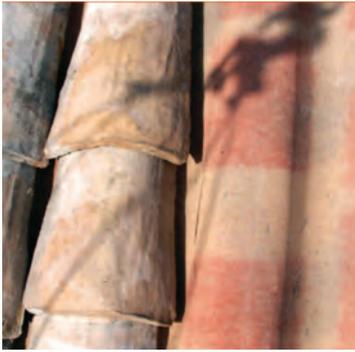
Les plaques sous-tuile ont été créées pour servir de support aux tuiles canal. Elles assurent la mise hors d'eau immédiate, l'étanchéité de la toiture et permettent d'alléger la charpente. Pour s'adapter aux tuiles canal des différentes régions, les plaques sous-tuile existent en plusieurs versions et longueurs.
