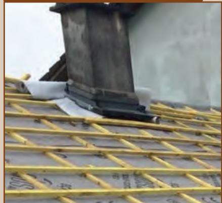
Une fois le chevêtre positionné, il convient de positionner un système déflecteur en position haute afin de dévier les écoulements éventuels. Attention, pour les cheminées, il est nécessaire de respecter l'écart au feu.
