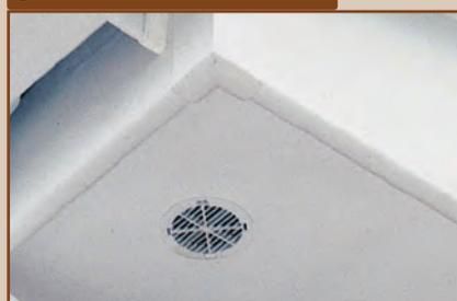
Prévoir des grilles (équipées d'une moustiquaire qui empêche le passage d'insectes) pour permettre une ventilation optimale de la sous-face (installation facile par clipsage).
