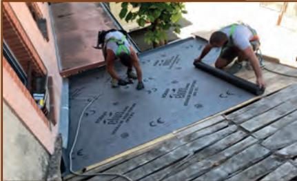
Déployer l'écran en le maintenant en tension, en démarrant en partie basse de la toiture parallèlement à la ligne d'égout. Les caractéristiques HPV de cet écran lui permettent d'être posé sur chevron, fermettes ou support continu. Poser en lés successifs en assurant le recouvrement défini par la pente du toit :
