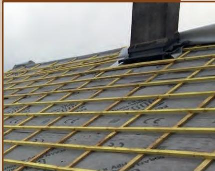
Dans le cas d'un faîtage ventilé, une bande d'écran sera soigneusement découpée et positionnée centrée en respectant un recouvrement de 20 cm de part et d'autre de la ligne de faîte.
