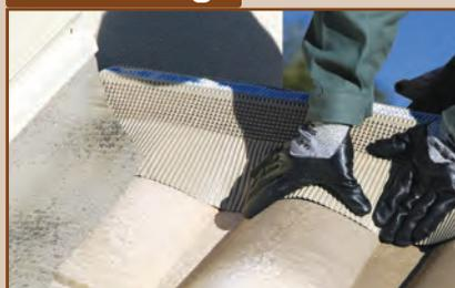
Maroufler la bavette du sommet du galbe de la tuile (couvert) vers le creux des tuiles (courant). Bien presser les bavettes contre les tuiles.
