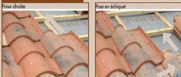
La pose débute par le rang d'égout, à droite ou à gauche selon le modèle de tuile. Les tenons doivent être en parfait appui sur la face amont du liteau. Les tuiles, une fois en place, doivent bien « plaquer », c'est-à-dire ne pas bouger lorsqu'on les sollicite de la main : il se peut qu'exceptionnellement une tuile ne plaque pas ; ne pas s'obstiner ni la jeter, elle trouvera plus loin sa place grâce au jeu des emboitements.
