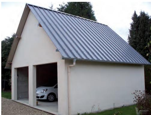
La toiture en bac acier se compose de plaques nervurées s'emboîtant les unes dans les autres afin d'assurer une toiture étanche.
