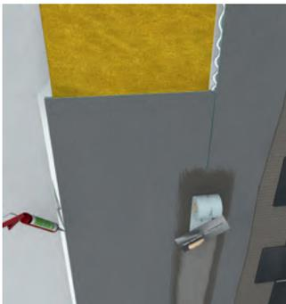
La grande variété d'application des panneaux de construction comprend également les ossatures bois et métal. Afin d'obtenir un support de carrelage propre ainsi qu'une construction stable, utiliser des panneaux de construction à partir de 20 mm d'épaisseur.
