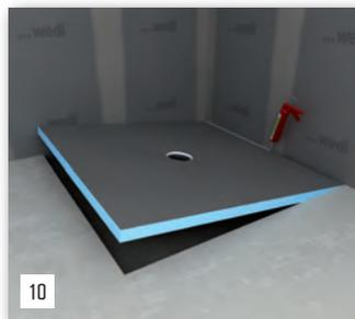
10 Plaquer le receveur sur son support, traiter les jonctions sol/mur en utilisant la colle polymère 610.
