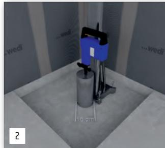
2 Pour la pose d'un écoulement vertical, faire un carottage d'un diamètre de 12 cm.
