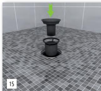
15 Carreler le receveur. Installer la tasse de siphon et la fermeture anti-odeurs.
