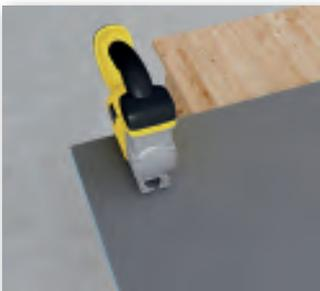
Découper le panneau de construction wedi en fonction des dimensions désirées pour la construction du meuble sur-mesure.
