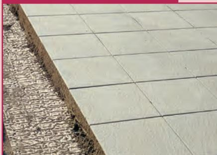
Le support, constitué d'un dallage seul ou d'un dallage associé à une forme de pente, a une pente minimale de 1,5% pour éloigner les eaux du bâtiment. L'épaisseur minimale du mortier de scellement est de 5 cm.
