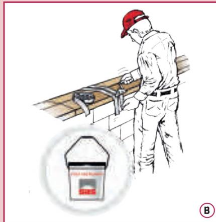
Faire un joint imperméabilisé entre chaque chaperon de mur de 0,5 cm minimum à 1 cm.
