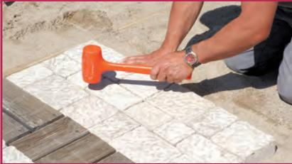
3 Ajuster la position des pavés à l'aide d'un maillet en caoutchouc.
