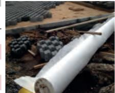
**GÉOTEXTILE DRAIN / SÉPARATION ET PROTECTION 8KN**
