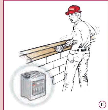
Mettre obligatoirement un hydrofuge de surface, en insistant sur le joint.
